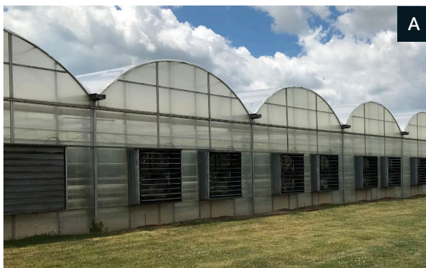
Figure 10. (A) Ventilateurs horizontaux traditionnels sur le côté d'une serre basse de tomates. (B) Ventilateur horizontal moderne au-dessus d'une culture de tomates dans une serre haute. (C) Ventilateur moderne traversant les rideaux.
