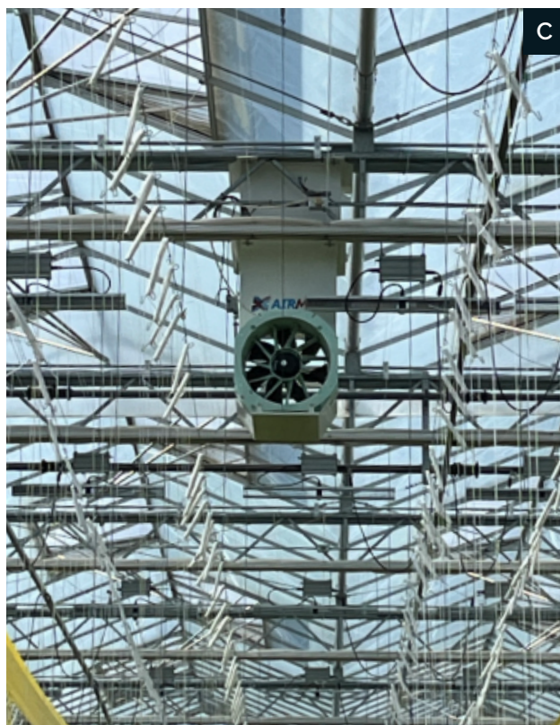
Figure 10. (A) Ventilateurs horizontaux traditionnels sur le côté d'une serre basse de tomates. (B) Ventilateur horizontal moderne au-dessus d'une culture de tomates dans une serre haute. (C) Ventilateur moderne traversant les rideaux.
