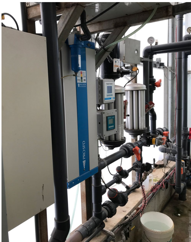
Figure 16. Système de filtration par osmose inverse.
